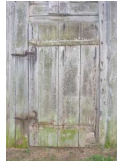
Mazirbe, saimniecības ēkas dēļu durvis ar kaltām eņģēm
