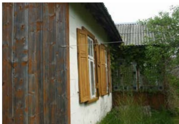
Sīkrags. Vinamegi dzīvojamā ēka, apmesta galvenā fasāde
