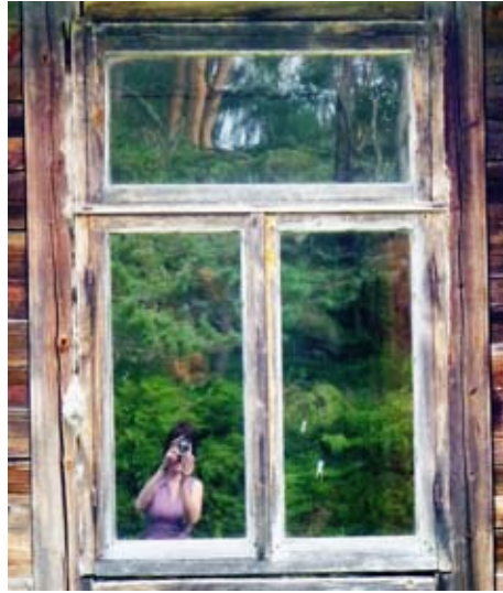
Mazirbes dzīvojamās mājas logs- T veida konstrukcijā
