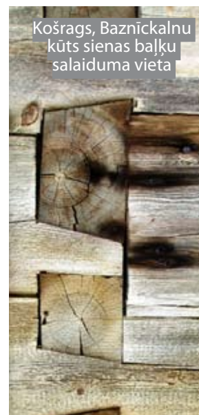
Saunags. Jūrnieku kūts siena, baļķu salaiduma vieta šķautņu gali ielaisti statņu vertikālajās gropēs
