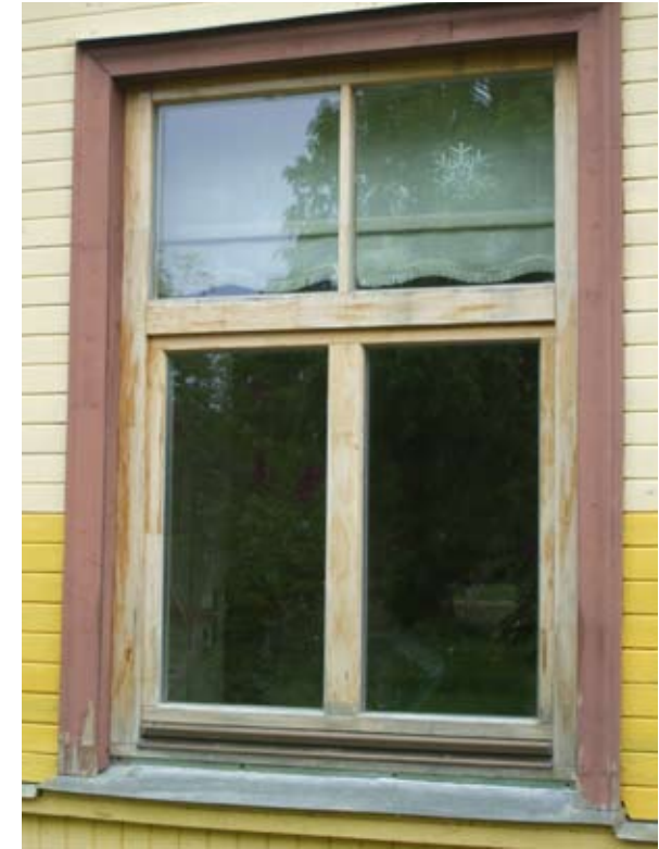
Sīkrags, Jaunklāvu dzīvojamās mājas logs nomainīts, saglabājot vēsturisko dalījumu
