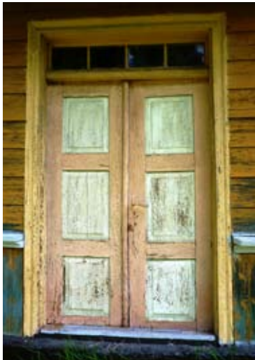
Vaide. Ozolnieku dzīvojamās mājas divvērtņu ieejas durvis ar virsgaismas logu
