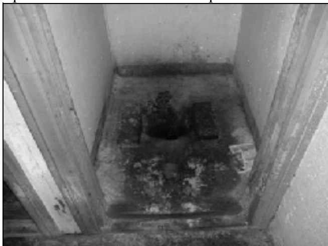
9.a attēls: Siguldas dzelzceļa stacijas tualete
