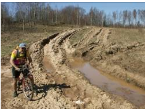
57. attēls. „Velomaršruta” segums Kurzemē, kas radies, izstrādājot cirsma
