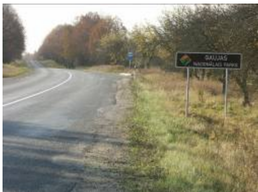
17. attēls. Autoceļa Valmiera – Cēsis sadēdējusī un velobraukšanai nepiemērotā ceļa nomale
