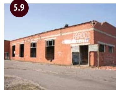
Sūkņu stacijas grausts pirms pārbūves (5.9. att.) un dzīvojamā ēka pēc tās (5.10. att.).
