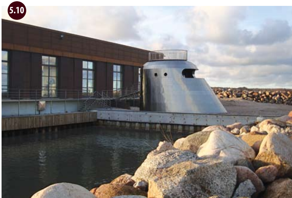
Sūkņu stacijas pārbūve par dzīvojamo māju.
